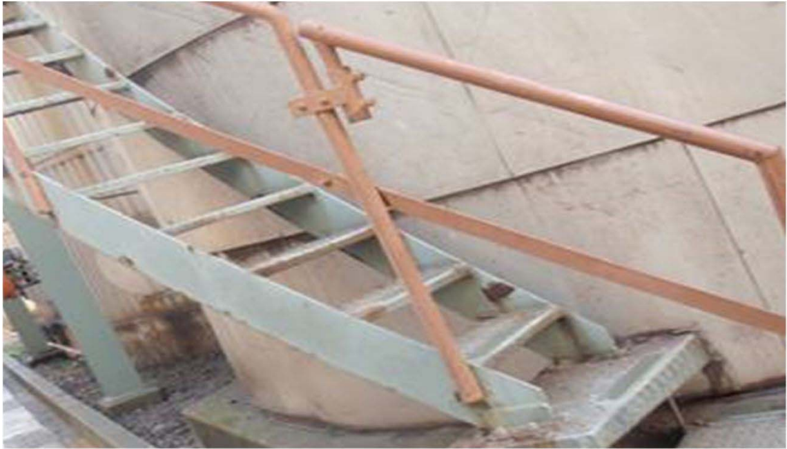
屋外の鉄階段に貼られたノンスリップテープ
