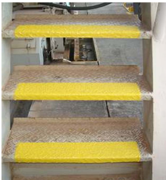
縞鋼板の階段
