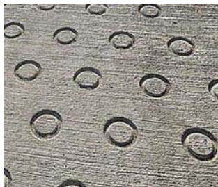
(真空コンクリート舗装)
