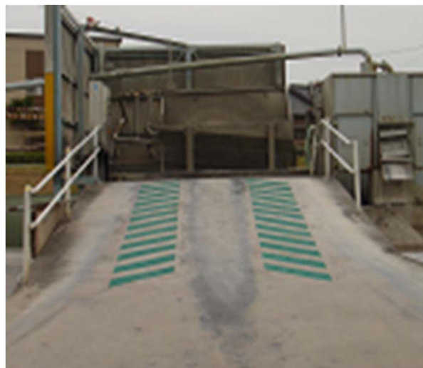
コンクリート斜路
